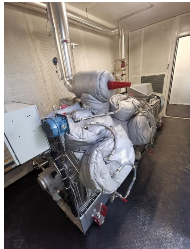
PAC THT installée chez Wepa Greenfield et couplée au système de séchage de la pâte à papier
