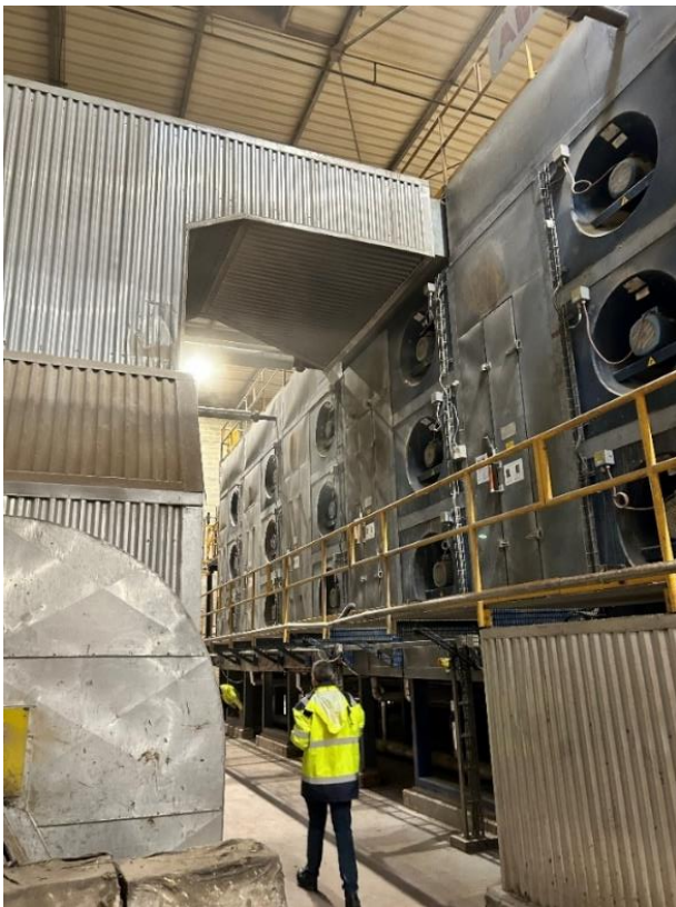
PAC THT installée chez Wepa Greenfield et couplée au système de séchage de la pâte à papier
